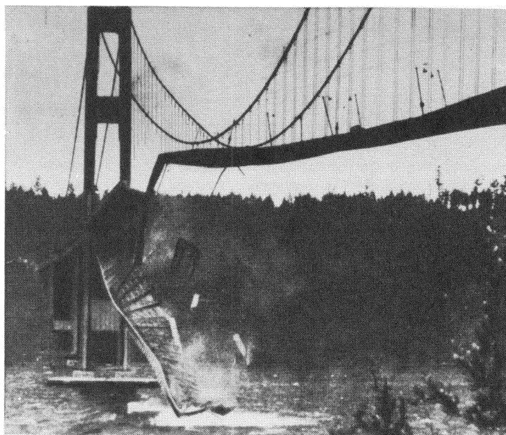
Rys. 15-21. W dniu 1 lipca 1940 r. został ukończony i otwarty dla ruchu most nad cieśniną Tacoma w Puget Sound, w stanie Washington. Most ten miał przęsło, które wówczas pod względem długości zajmowało trzecie miejsce na świecie. Zaledwie w cztery miesiące później, niezbyt silna wichura wprawiła most w takie drgania, że główne przęsło zostało złamane i po oderwaniu się od lin runęło do wody. W wyniku działania wiatru o stałej prędkości powstała siła fluktuująca, będąca w rezonansie z drganiami własnymi konstrukcji. Spowodowało to tak silny wzrost amplitudy, że most został zniszczony. Po tym wypadku poprawiono konstrukcję wielu innych mostów, aby uczynić je stabilnymi pod względem aerodynamicznym
